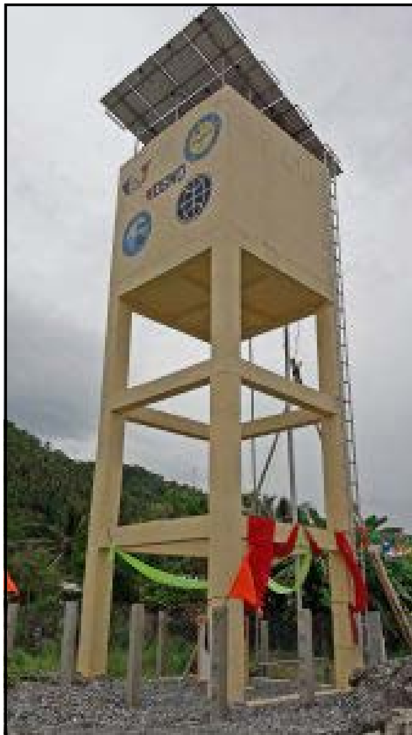
Naitayo na ang 816 L.M Solar Pump Driven Level II Water System na pangunahing naghahatid ng inuming tubig sa Lungsod ng Daan.
